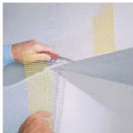
Връзка на топлоизолацията с подпрозоречна дъска
