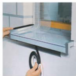
Уплътняване на фугите между топлоизолацията и подпрозоречна дъска с уплътнителна лента
