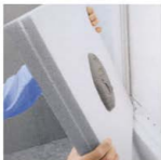
Монтиране и закрепване на топлоизолационните плочи с помощта на шини.
