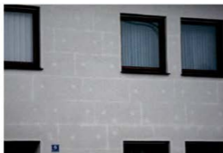
Фасада със светли петна, предизвикани от дюбели с голям коефициент на точково топлопреминаване
