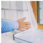
Връзка на топлоизолацията с подпрозоречна дъска
