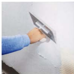
Топлоизолиране в областта на цофъла
