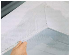
Завършване на водооткапващ профил
