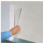
Монтиране и закрепване на топлоизолационните плочи с помощта на шини.
