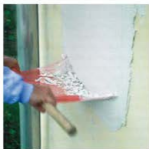
Полагане и вграждане на армираща мрежа
