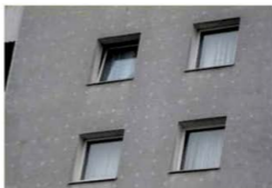
Фасада със светли петна, предизвикани от дюбели с голям коефициент на точково топлопреминаване
