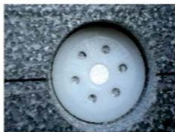
Фасада със светли петна, предизвикани от дюбели с голям коефициент на точково топлопреминаване
