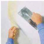
Армираща мрежа с прекриване
