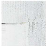
Армиране с ръбоохранителен ъглов профил с мрежа
